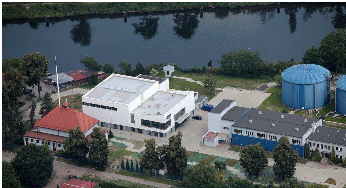
Rysunek 1. Stacja Uzdatniania Wody w Gliwicach widziana z lotu ptaka
